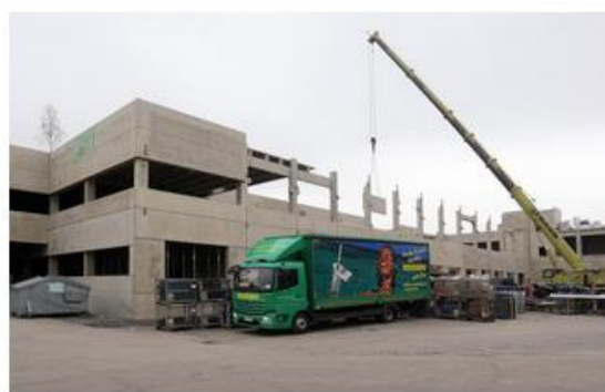
Auf dem Areal an der Ecke Etzelstraße/ Gottlieb-Daimler-Straße errichtet der Großhändler Reisser ein neues Logistikgebäude mit Büros. Foto: Andreas Veigel
