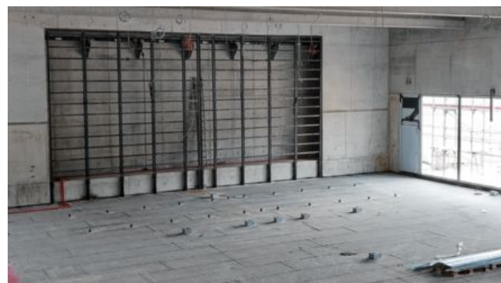
Die neue Mehrzweckhalle in Lauchheim erhält Deutschlands größte Klappbühne.
