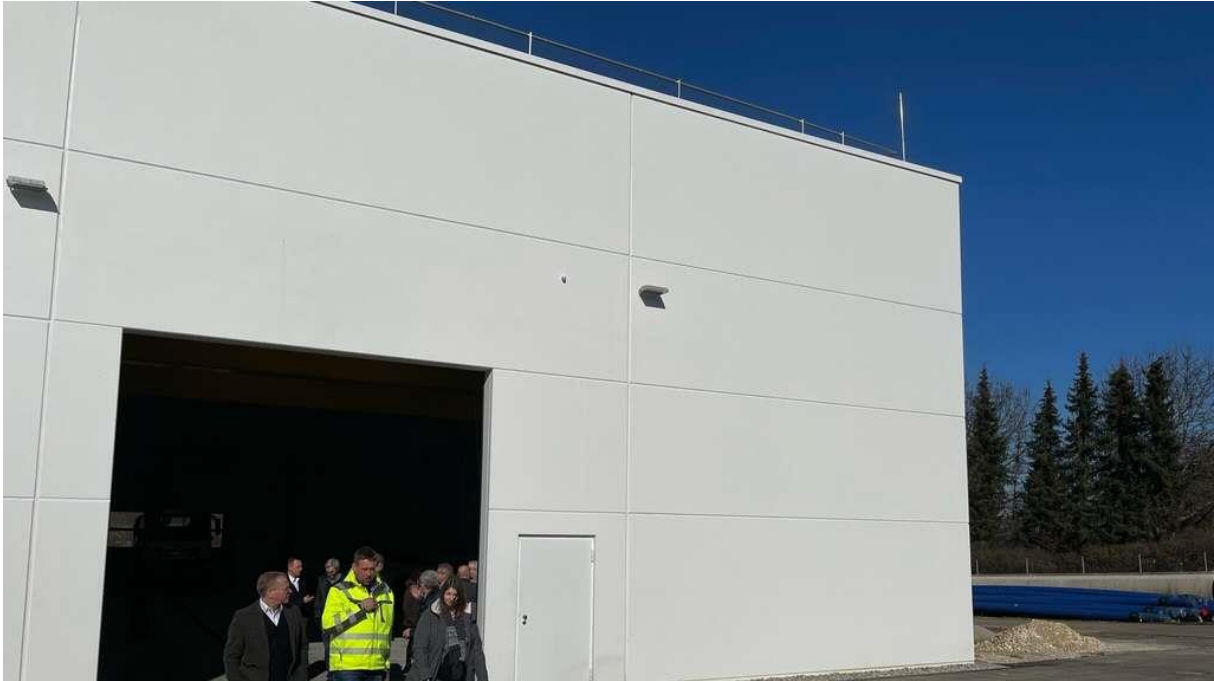
Die neue Rohrlagerhalle der Betriebsstelle Essingen des Zweckverbands Landeswasserversorgung.
