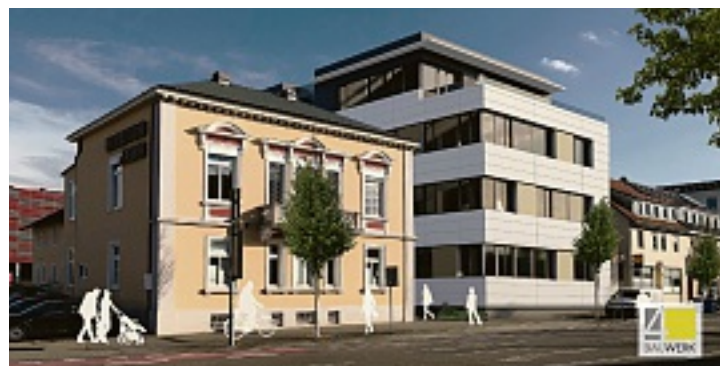
Der Anbau von Elektro Jerg in der Aalener Bahnhofstraße schließt eine Lücke im städtebaulichen Ensemble.
