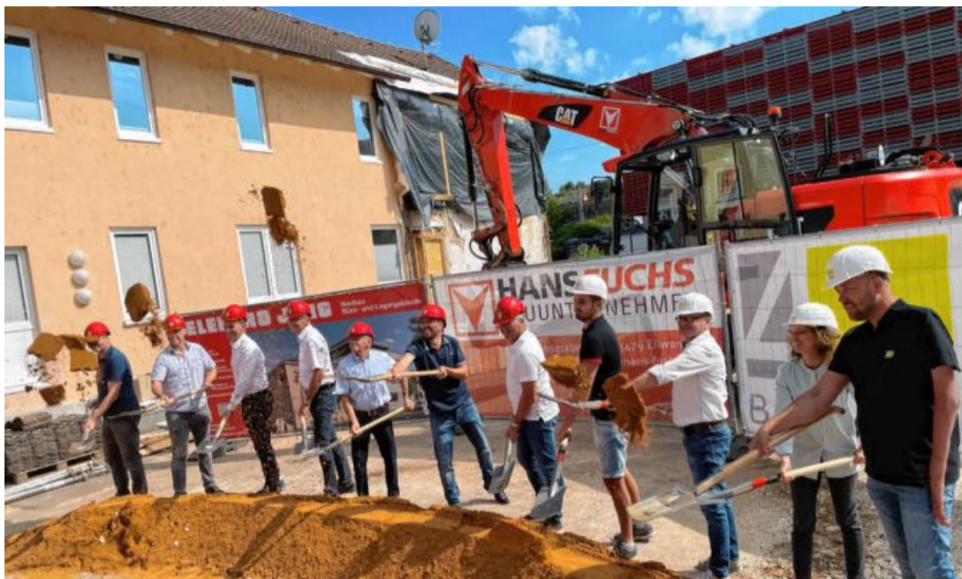
Spatenstich bei Elektro Jerg, Firmenchef Ulrich Betzler als Fünftler von links.
